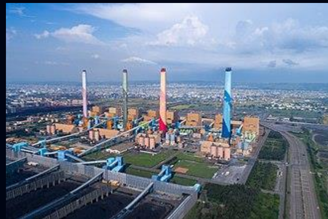
臺中火力發電廠
