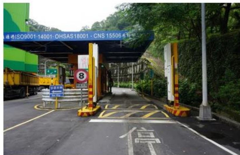
垃圾焚化廠之門框式輻射偵檢器
